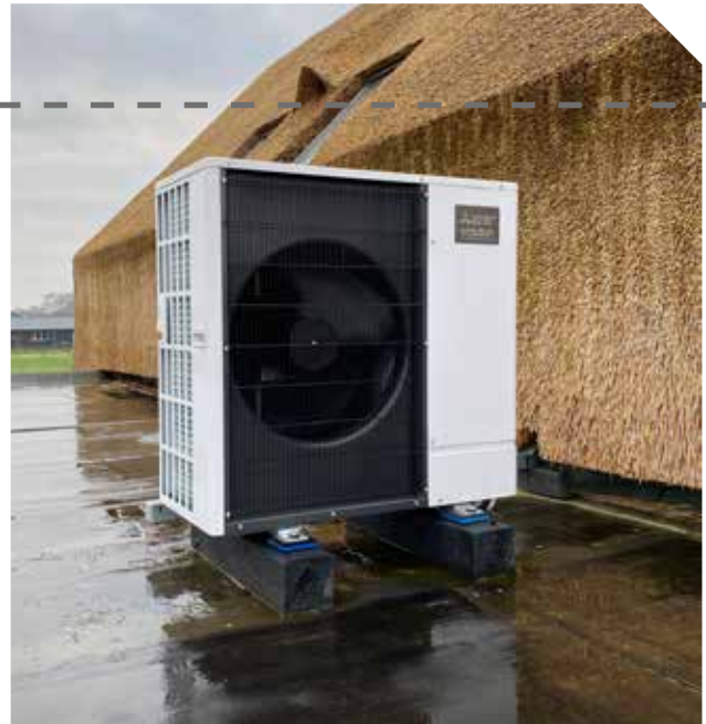
De buiten-unit onttrekt energie (warmte) aan de buitenlucht.
