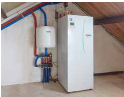
Voorbeeld van een cilinderunit-opstelling met (ingebouwd) 200 liter boiler en een 40 liter buffervat.
