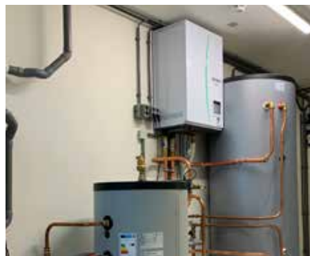
Voorbeeld van een hydrobox-opstelling met een 300 liter boiler en een buffer van 100 liter.
